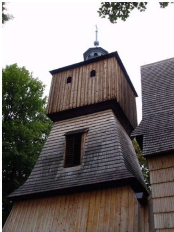
Wieżę dobudowano dopiero w XVII wieku
