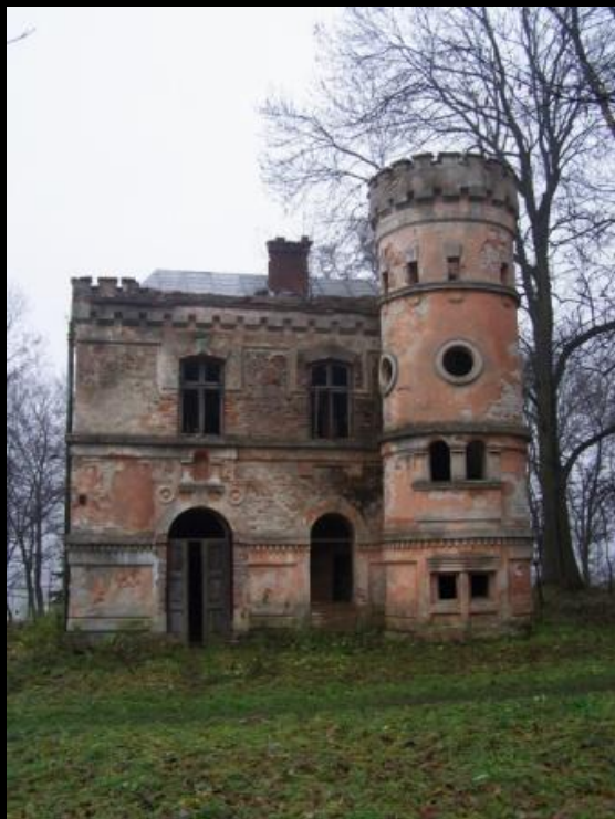
Narożna wieża jest główną ozdobą pałacu
