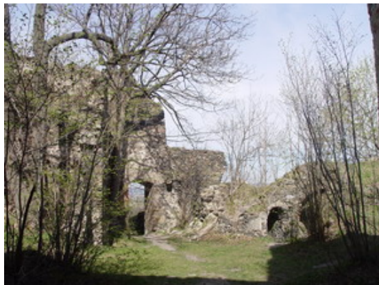
...i nieco bardziej zniszczony dziedziniec zamku średniego
