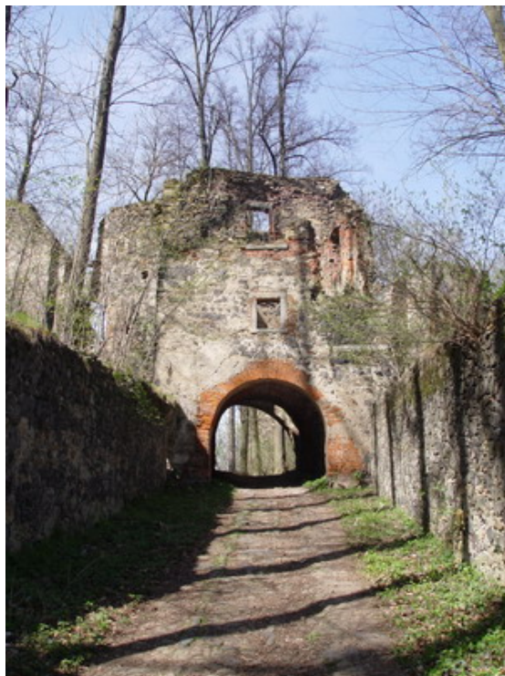
Brama wjazdowa do zamku z drogą otoczoną murami
