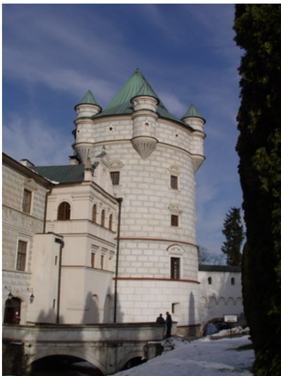
Baszta Królewska przy wejściu do zamku
