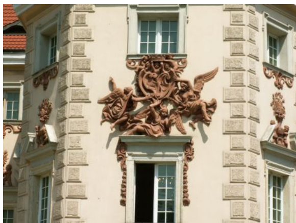
Fragment dekoracji elewacji
